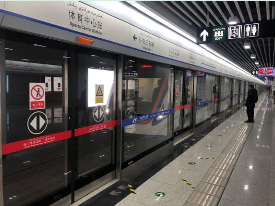
乌鲁木齐轨道交通一号线正常运营
