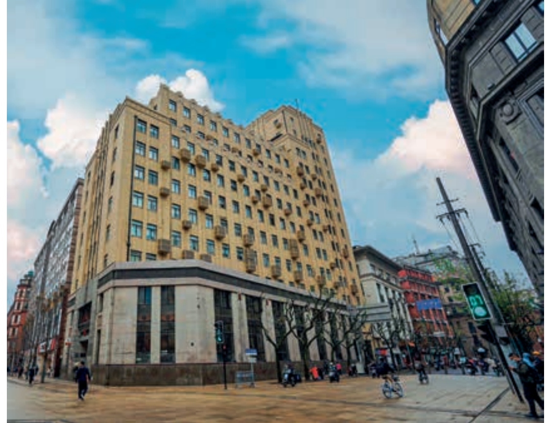
中国工商银行上海市黄浦支行本部大楼。
