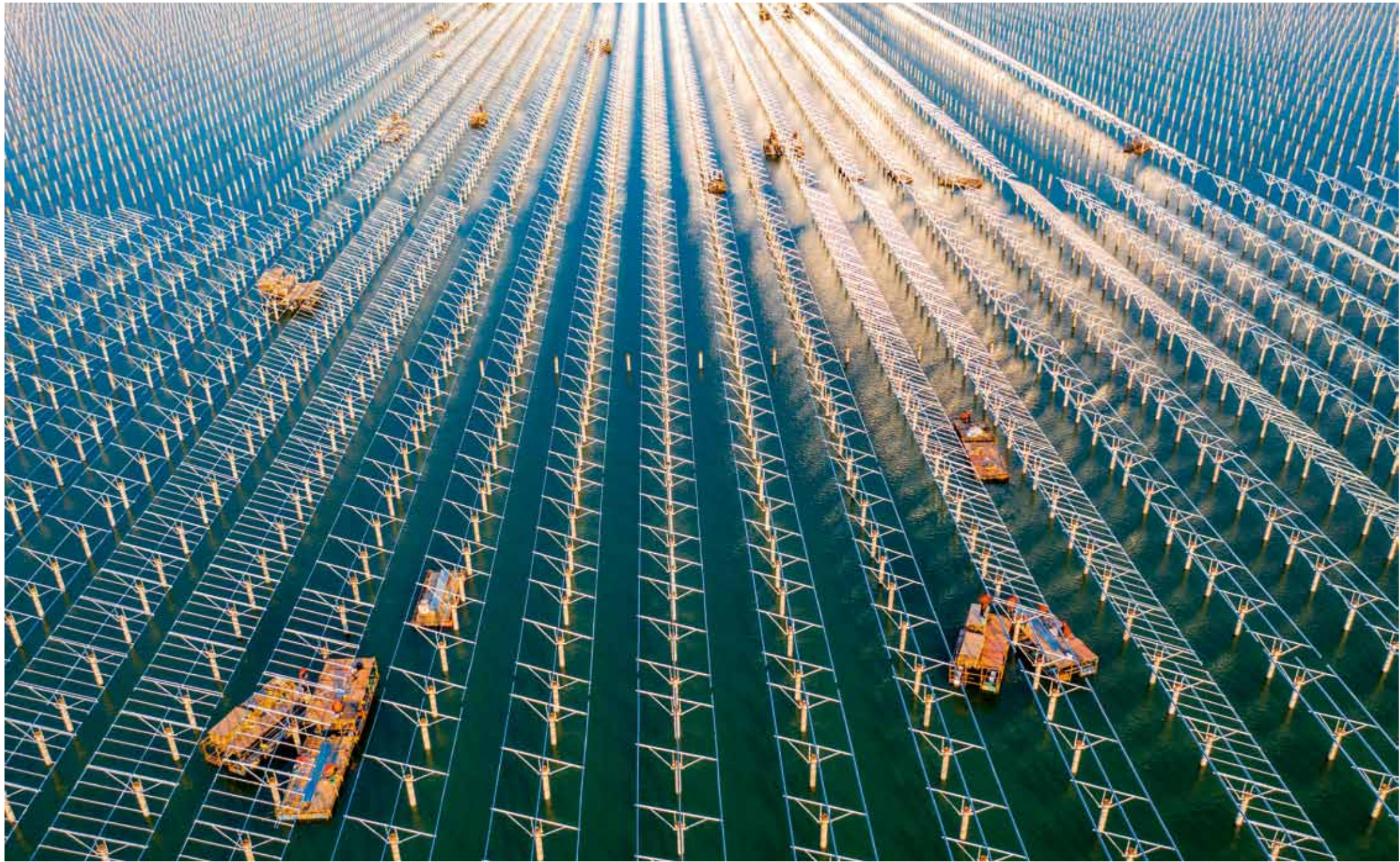
2021年3月4日，安徽合肥市肥东县杨店乡大李水库渔光互补光伏电站项目施工现场，工人们在浮船上安装光伏板支架。 图/中新
