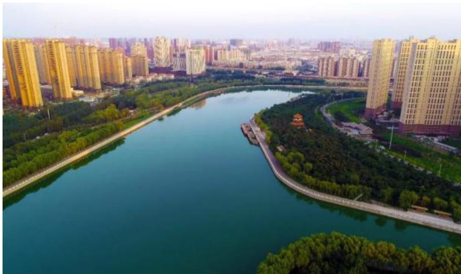
伊通河水系治理工程
